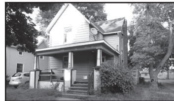
Property 3309 - Lansing 712 N. Sycamore St.
